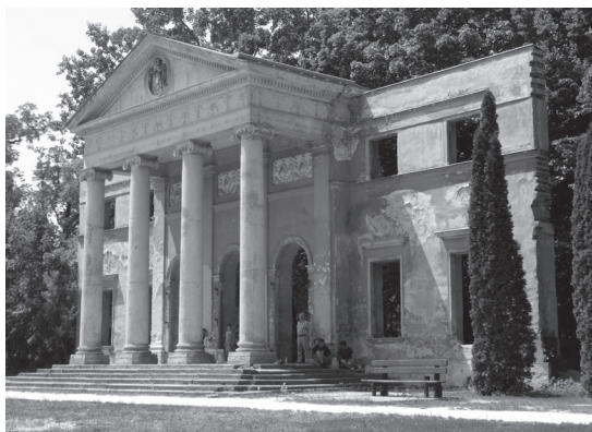
Alcsút, a II. világháború végén elpusztított Habsburg-kastély konzervált homlokzat-maradványa az arborétumban (fotó: Lővei Pál, 2011)
